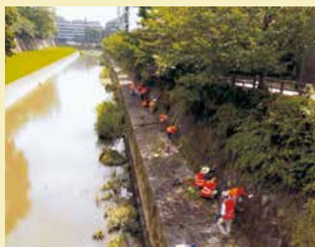
夏草におおわれた坪井川沿い(御幸橋付近)を清掃 (H29.7月)
