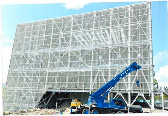
令和7年4月13日撮影（素屋根で覆われている）
