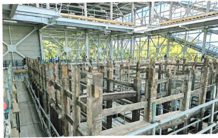
令和7年4月13日撮影（小屋組みが現われた）
