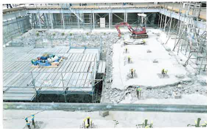
令和7年6月15日撮影（小屋組みが取り払われた）
